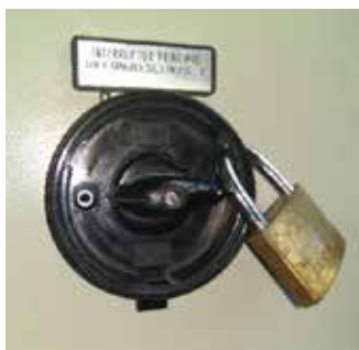
Figura 6. Bloqueo de un seccionador mediante candado.
